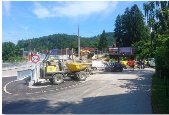
12.08.2021: Bei Baggerarbeiten wurde in der Moartalstraße eine Erdgasleitung beschädigt. Das Gebiet sperrte man großräumig ab und führte Messungen durch. Die Leitung wurde von der Salzburg AG abgedreht.
